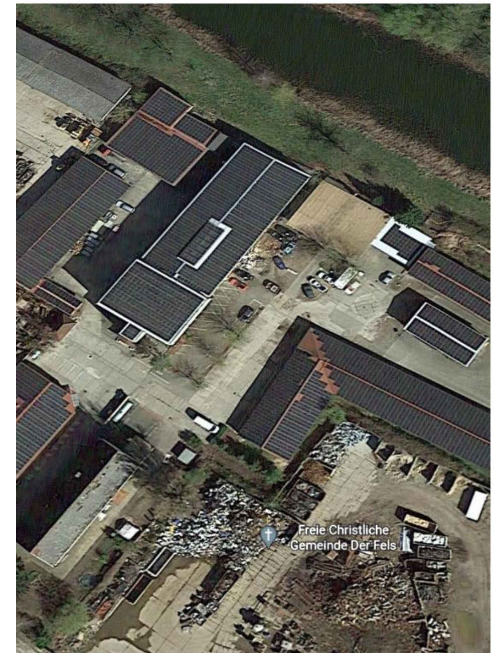
Landwirtschaftlicher Betrieb Lauenburg 741 kWp
