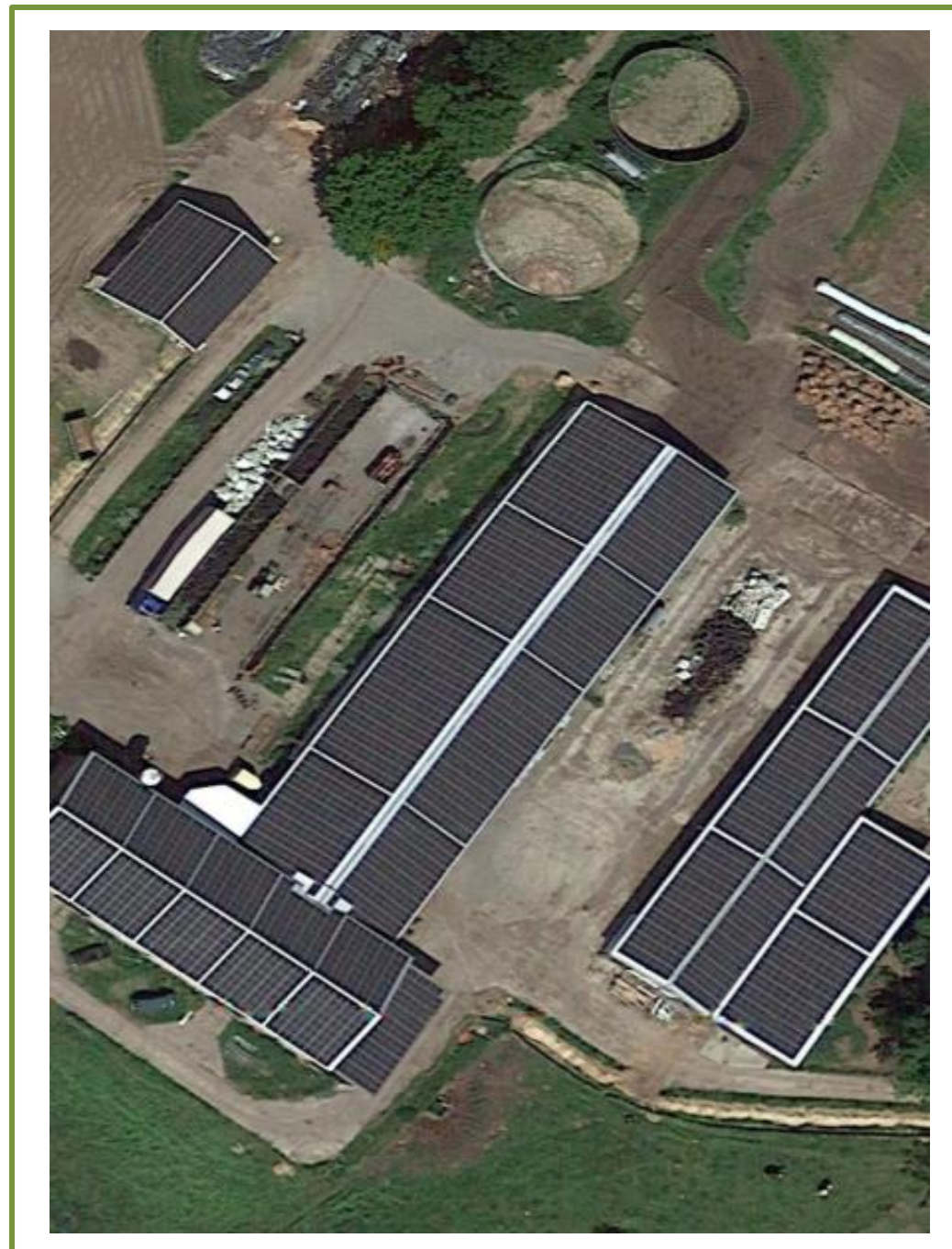
Mehrzweckhalle Groß Rosenberg 268 kWp
