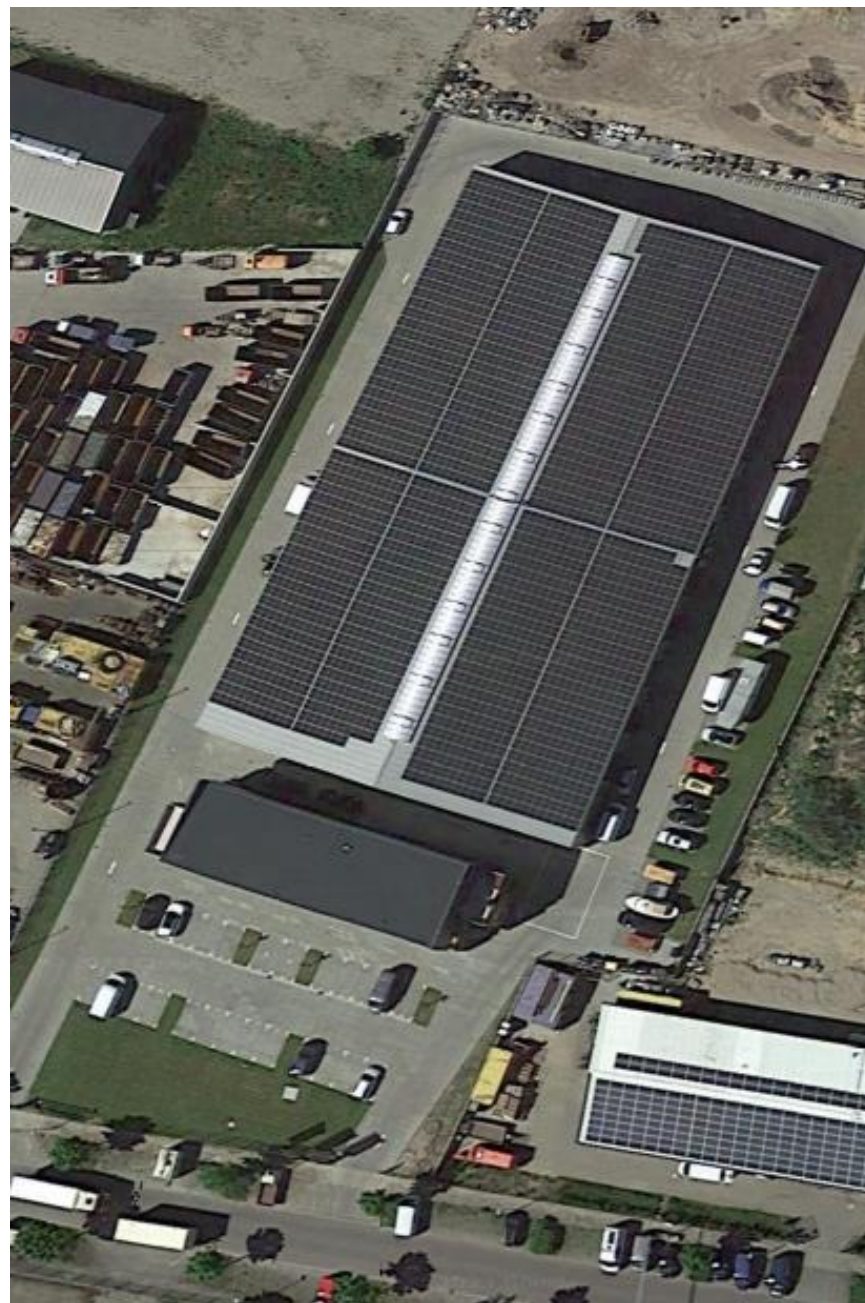
Gewerbecampus bei Berlin 749 kWp
