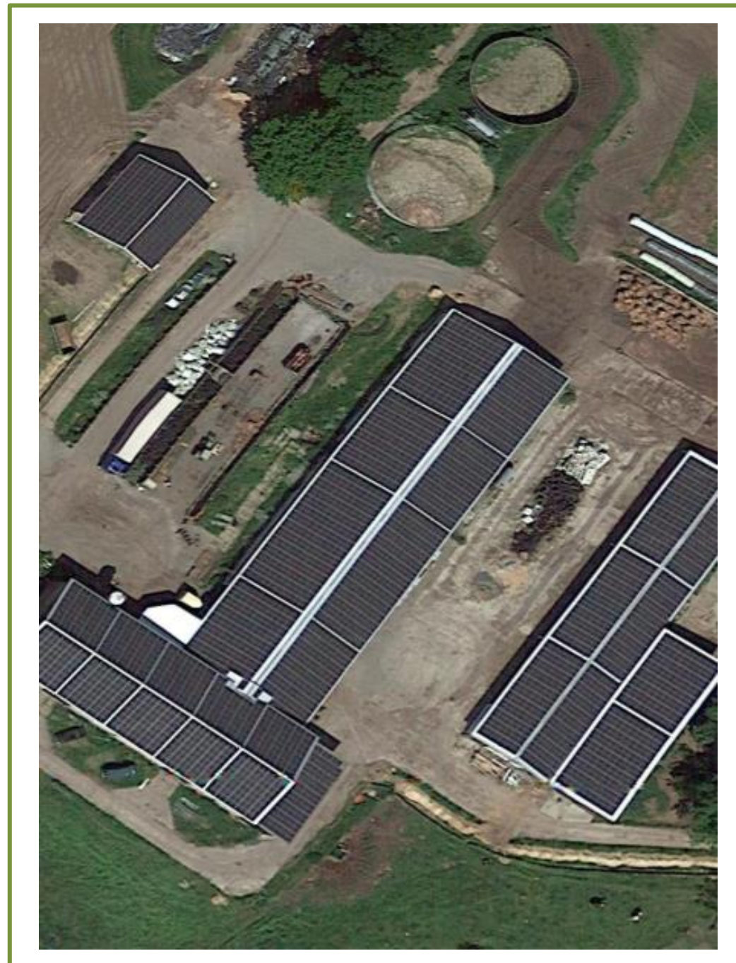
Mehrzweckhalle Groß Rosenberg 268 kWp
