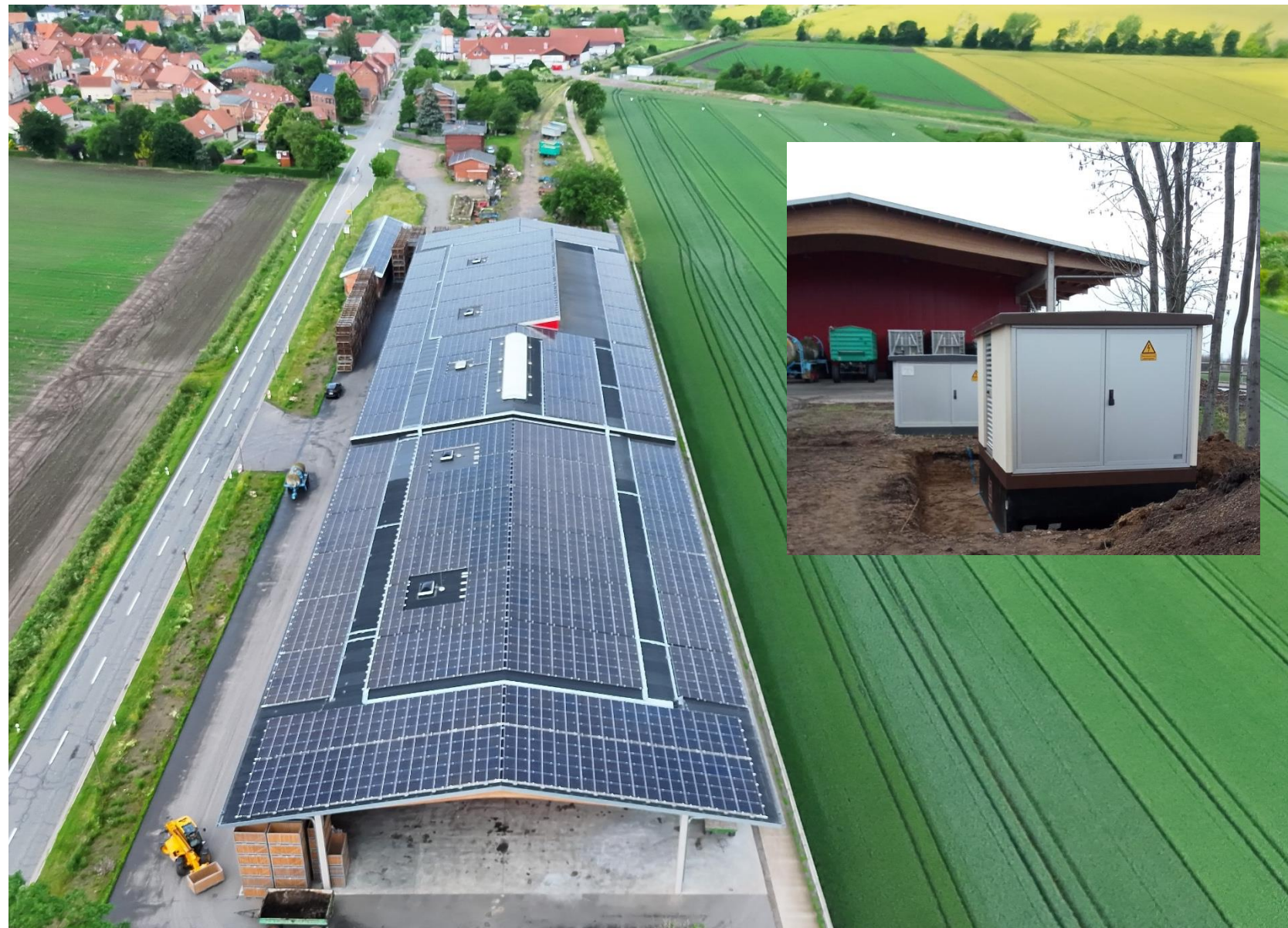
Lagerhalle in Dingelstedt 999 kWp auf 2 Dächern
