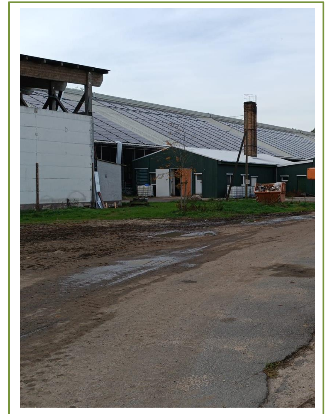
Landwirtschaftlicher Betrieb Nähe Bad Freienwalde 945 kWp
